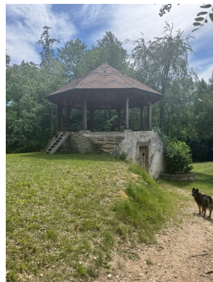
8 – La glacière et son toit garni de tuiles vernissées.
