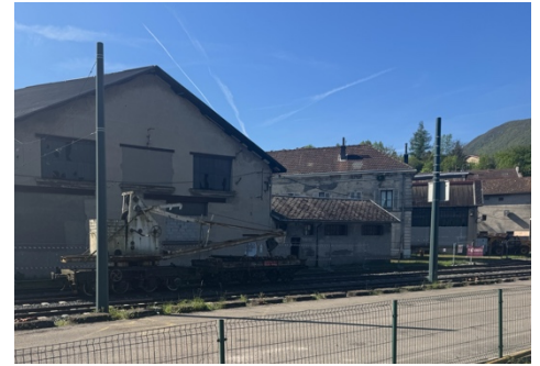
2 - La grue devant les bâtiments où sont stockées les merveilles du site.
